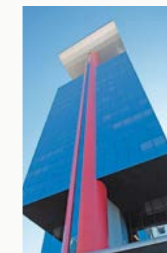
Edifício Joaquim Floriano
