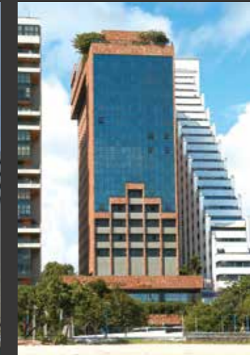
HOTEL GRAN MARQUISE - FORTALEZA
