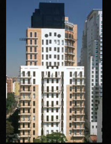
EDIFÍCIO GAND LOFT I
